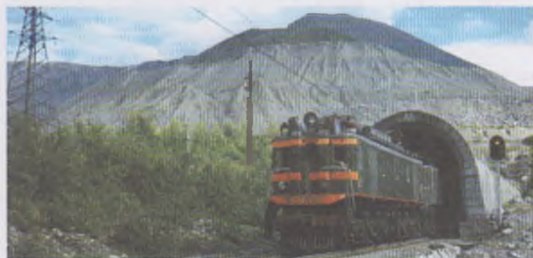
Рис. 27. Тоннель в Хибинах
