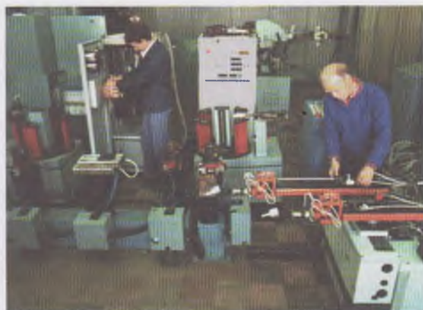
Рис. 101. Монтажники собирают станки
